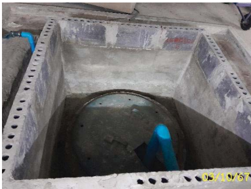
บ่อบำบัดและถังเก็บน้ำใช้ใต้ดิน
